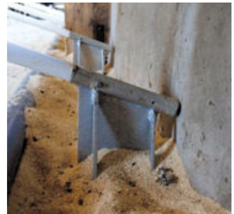
De galvaniseerde houders worden op de vlakke betonnen vloer geschroefd.
